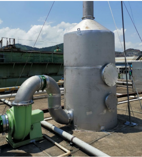
> 污水处理站臭气吸附塔由 PP 材质更换为不锈钢材质
