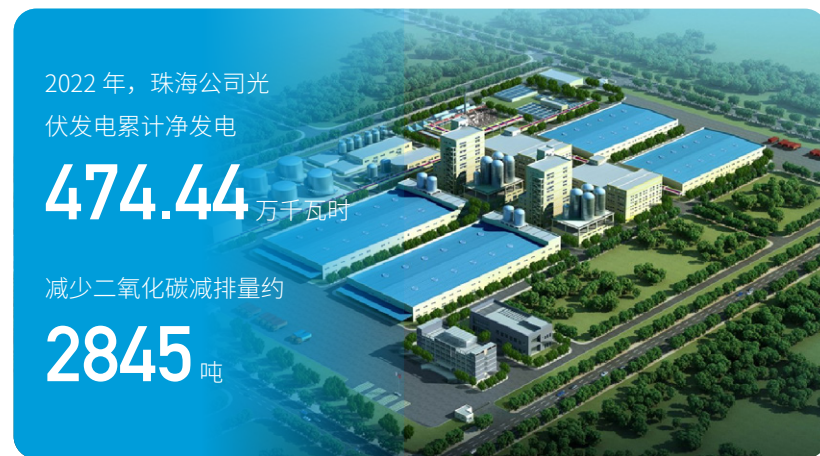
珠海公司光伏发电项目总体鸟瞰图
